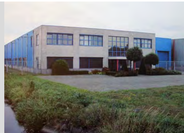
Middelweg 23 september 2009: In dit kantoor en in een gedeelte van de hal zijn optieketen Eyelove, Samuels Interieur en Broceliande theaterproducties gevestigd.
