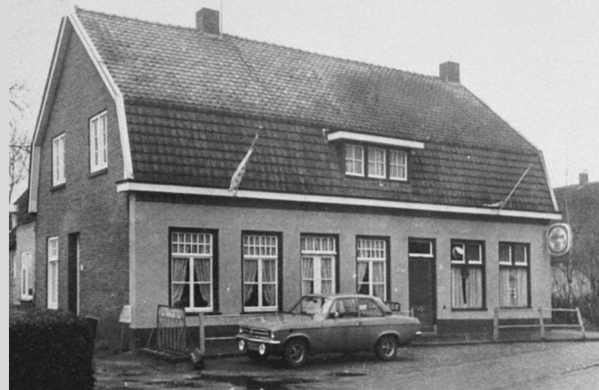
Café en woonhuis in de Meliestraat 34 Vlijmen. Gebouwd omstreeks 1900. In 1915 werd het zadeldak vervangen en kwamen er spouwmuren.
